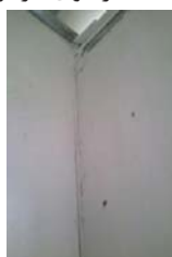
شکل ۴- جدایی دیوار پرکننده موازی با جهت شتاب اعمالی (In Plan) تحت شتاب 0.7g از قاب
