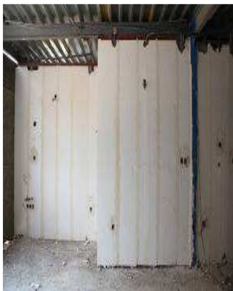
شکل ۲۰ نمونه‌ای از اجرای پانل در سقف فلزی
