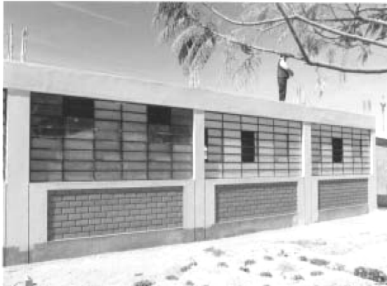
شکل ۱۲- پتانسیل شکست ستون کوتاه در یک مدرسه
