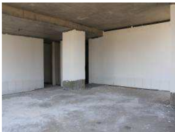
شکل ۱۸ ظاهری مناسب بعد از اجرا
