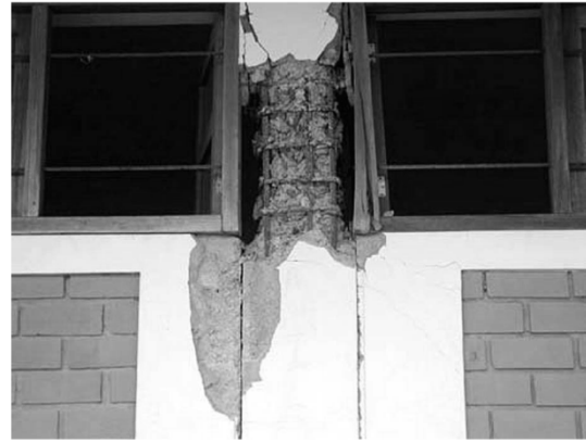
شکل ۱۱- نمونه‌ای از شکست ستون کوتاه
