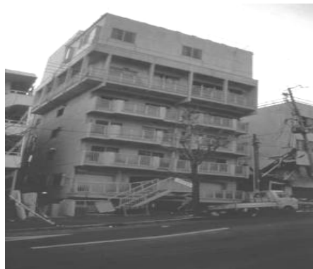
شکل ۸- انهدام طبقه‌ی همکف ساختمان بتنی به علت پیچش، (کوبه، ۱۹۹۵)
