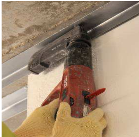
شکل ۱۴ اتصال نبشی ورقی به سقف با کمک میخ، ایجاد تکیه‌گاه مناسب برای پانل
