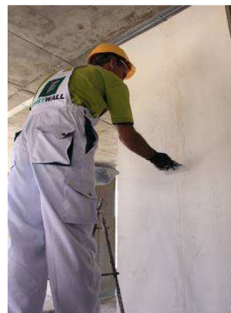
شکل ۱۵ اتصال دو المان پانل بوسیله نوار و رزین مخصوص
