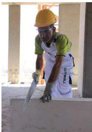
شکل ۱۶ امکان تقسیم پانل به قطعات مورد نیاز
