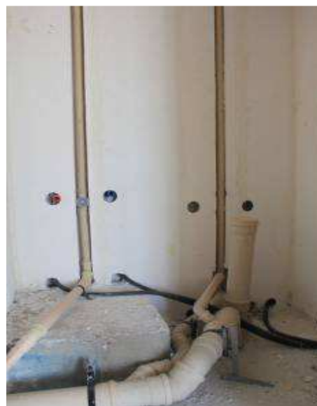
شکل ۱۹ امکان اجرای تأسیسات بدون آسیب به رفتار پانل
