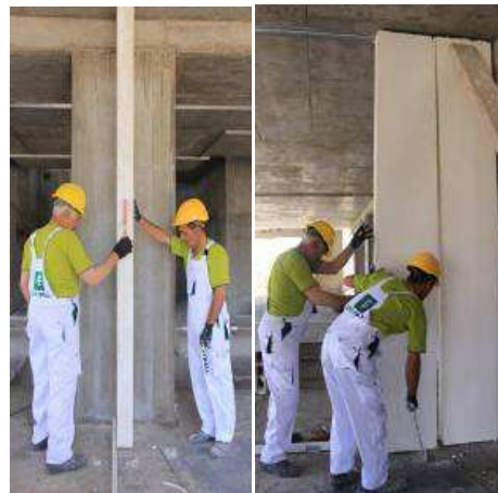
شکل ۱۳ شاقول کردن پانل، قرار دادن پانل در محل نصب
