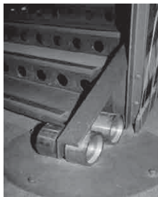
شکل ۱۹: جداسازی راه پله از سازه با استفاده از غلطک در پایه (چارلسون، ۱۳۹۰)
