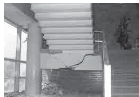
شکل ۱۱: نمونه ای از شکست پای پله در محل دال پاگرد در زلزله ۱۹۸۵ مکزیکوسیتی (تابش پور، ۱۳۹۴)
