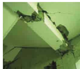
شکل ۱۰: نمونه‌ای از شکست تیر پای پله (Feng, et al, ۲۰۱۳)
