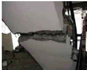
شکل ۸: نمونه‌ای از شکست دال بتنی پله (Feng, et al, ۲۰۱۳)
