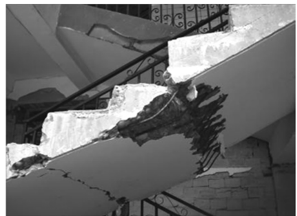
شکل (۸): نمونه‌ای از شکست دال پله در زلزله ۲۰۰۸ ونچوان چین [۲۱].
