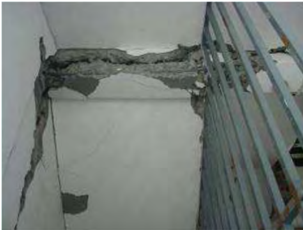
شکل (۱۰): نمونه‌ای از شکست پای پله در محل دال پاگرد [۱۲].
