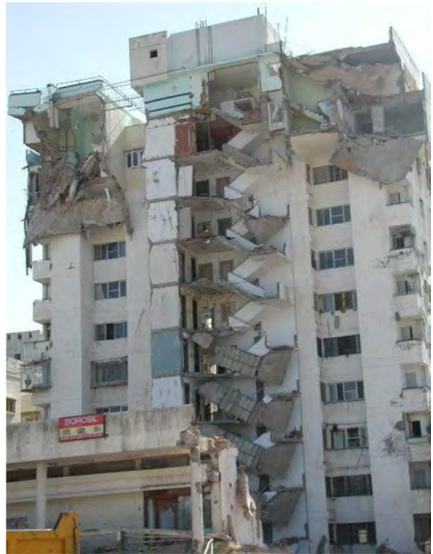
شکل (۱۵): شکست پله در اثر شکست سازه کنسولی پاگرد در زلزله ۲۰۰۱ گجرات هند [۲۲].
