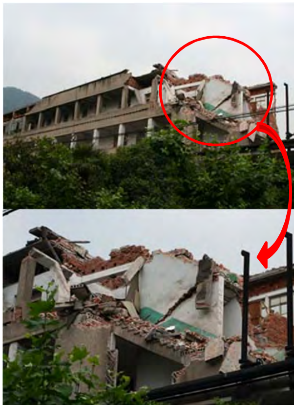
شکل (۵): نمونه‌ای از خرابی سازه در محل پله در زلزله‌ی ۲۰۰۸ ونچوان چین [۱۹].
