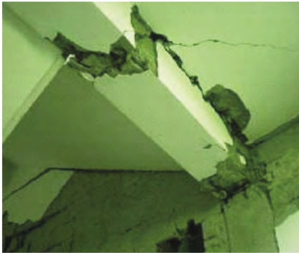
شکل (۹): نمونه‌ای از شکست تیر پای پله [۴].
