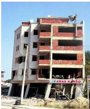
شکل ۲- ایجاد طبقه نرم در اثر حذف دیوارهای آجری طبقه همکف در زلزله ۱۹۹۹ کوکایلی ترکیه [۱۱]
