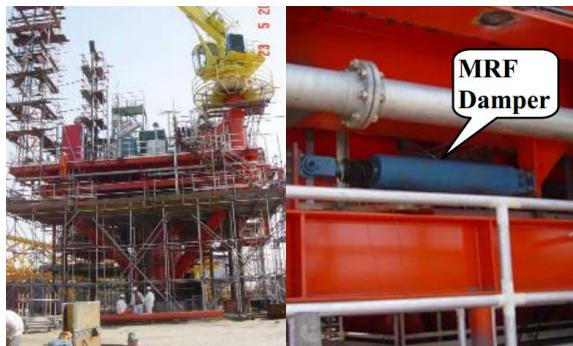
شکل ۱۳. نصب میراگر آم. آر. در سکوی جاکت
