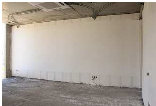
شکل ۱۲- پانل کامپوزیت اجرا شده در فضای داخلی و نمای یک ساختمان بلند مرتبه
