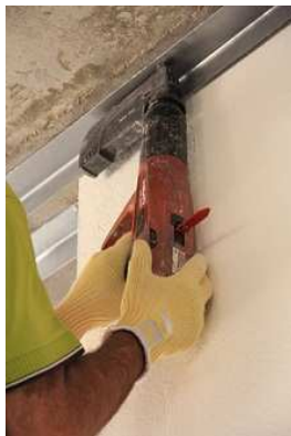
شکل ۱۱- نحوه مهار پانل به سقف
