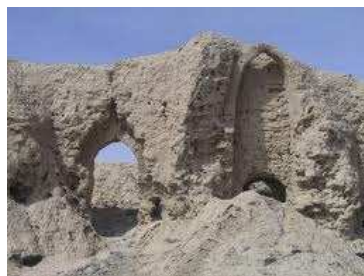
شکل ۱: استفاده از چینه در ساخت دیوار حصارها در زمان گذشته [www.sistaniha.info]
