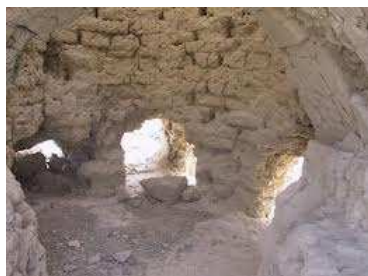
شکل ۱: استفاده از چینه در ساخت دیوار حصارها در زمان گذشته [www.sistaniha.info]
