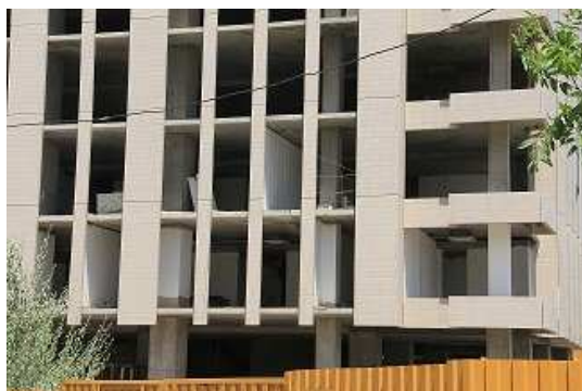
شکل ۱۲- پانل کامپوزیت اجرا شده در فضای داخلی و نمای یک ساختمان بلند مرتبه
