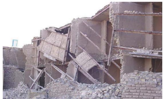
شکل ۲۵ ریزش سقف به علت شکست دیوارهای باربر و عدم انسجام سقف (به جهت تیرریزی توجه شود).
