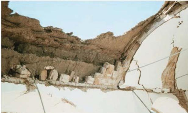
شکل ۳۹ شکست سقف قوسی (بم)
