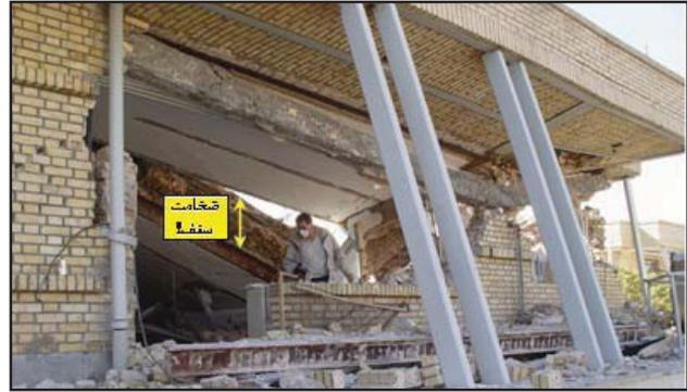
شکل ۱۹ شکست سقف به علت عدم انسجام و عدم اتصال به دیوار (بم). به وزن زیاد سقف توجه شود!
