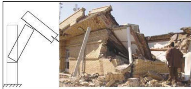
شکل ۲۰ ریزش سقف به علت عدم اتصال به دیوار (بم)
