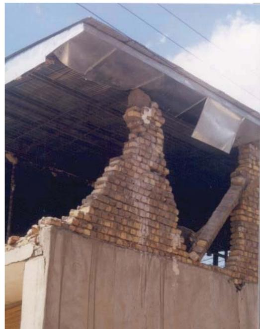
شکل ۳۳ آسیب‌پذیری شدید سقف و احتمال ریزش؛ (در صورت شکست باقی‌مانده‌ی دیوار باربر، سقف کاملاً فرو می‌ریزد.)
