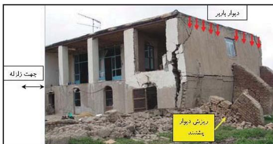
شکل ۳۴ شکست خارج از صفحه‌ی دیوار مرتفع به علت عدم اتصال به سقف میانی (به وجود پشت‌بندها قبل از زلزله توجه شود.)
