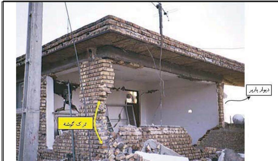
شکل ۳۲ کاربرد کلاف افقی به جای تیر حمال (اجرای نامناسب اتصال کلاف افقی و دیوار باعث ریزش خارج از صفحه‌ی دیوار غیرباربر شده است. عدم وجود کلاف قائم باعث جدا شدن دیوارها در گوشه‌ها از یک‌دیگر شده است.)
