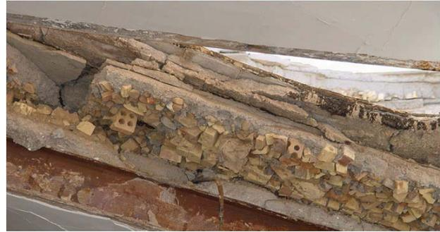
شکل ۳۶ انباشت نخاله ها در سقف و سنگین شدن آن (بم)
