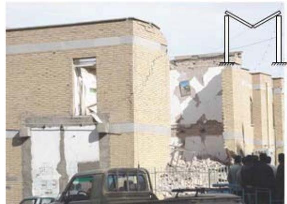
شکل ۲۴ شکست دیوار در حالت سقف بسیار انعطاف پذیر و یا عدم وجود اتصال مناسب بین آن با دیوارها
