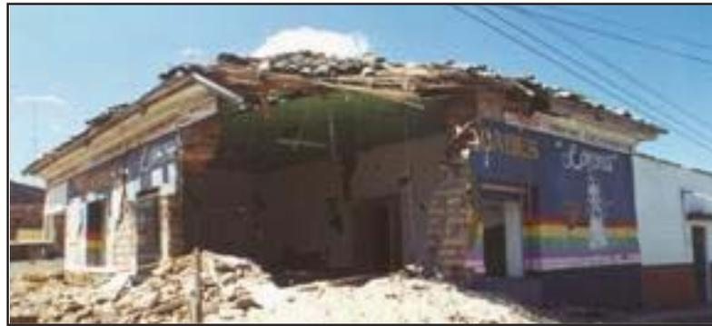
شکل ۱۶ ریزش دیوار غیرباربر و انسجام سقف
