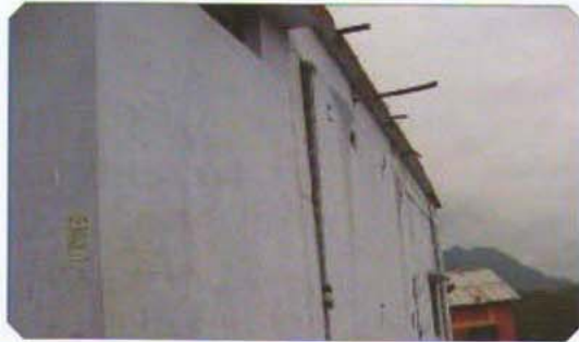
شکل ۱۰- شکست خارج از صفحه دیوار و چرخش آن مانند یک جسم صلب (اندونزی)
