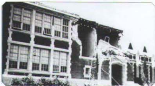
شکل ۱۲- خرابی و شکست خارج از صفحه ایجاد شده در ساختمان مدرسه (کالیفرنیا ۱۹۳۳)
