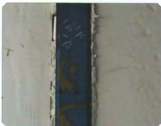
شکل ۲۵- اجرای درز بین دیوار و ستون و پر کردن آن با مصالح فوم (پانل کامپوزیت مسلح با نام تجاری ایزی وال)
