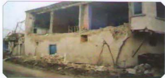
شکل ۱۵- شکست خارج از صفحه دیوارهای طبقه دوم
