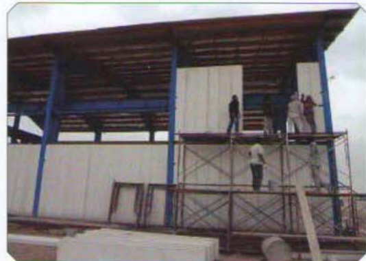
شکل ۲۷- اجرای پانل‌های کامپوزیت مسلح در سوله
