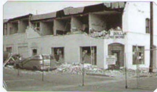
شکل ۱۴- نمونه ای از شکست خارج از صفحه دیوار
