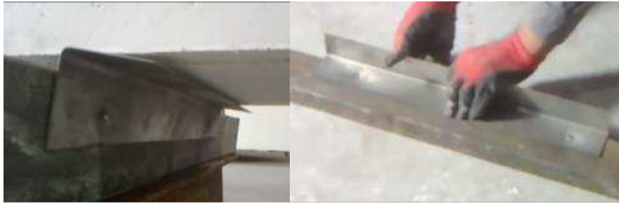
شکل ۶ اتصال نبشی تکیه گاهی
