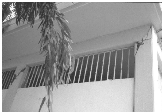
شکل ۱۷- شکست ستون به علت اندرکنش با دیوار پرکننده
