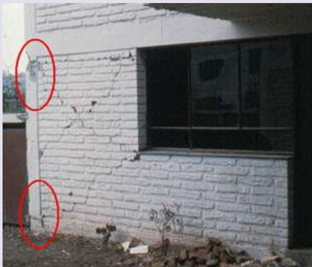
شکست برشی کلاف قائم در دیوار آجری محصور شده
