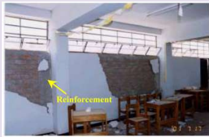
شکل ۲-۲۶- عدم شکست ستون کوتاه در یک مدرسه به دلیل وجود ماده نرم بین دیوار و قاب
