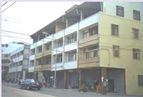
شکل ۱-۱۵- پتانسیل شکست توأم پیچشی و طبقه نرم
