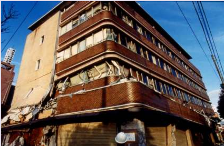
تخریب یک ساختمان به علت نادیده گرفتن اثر سختی دیوار (کوبه ۱۹۹۵)
