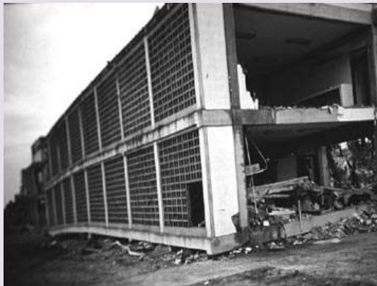
شکل ۱-۷۲- نمایی از ساختمان قبل از زلزله شکل ۱-۷۳- تخریب کامل طبقه اول در هنگام زلزله به علت پدیده ستون کوتاه
