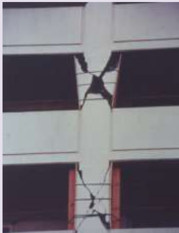
شکل ۸۷-۱- اقداماتی برای ایمنی موقت در شکست ستون کوتاه
