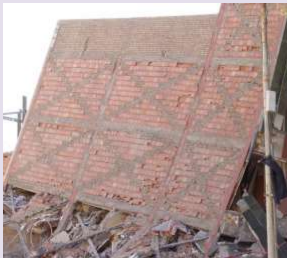
شکست طبقه نرم (در ترکیب با پیچش مختصر)
