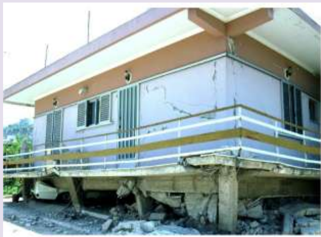
شکل ۱-۷۹- شکست ستون کوتاه در طبقه زیر زمین
