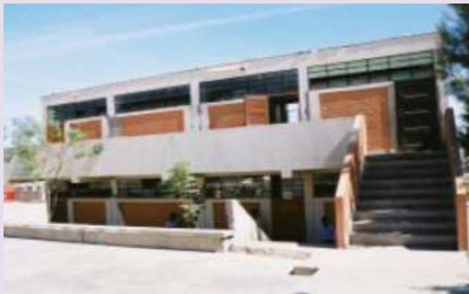
شکل ۱-۸۵- پتانسیل شکست ستون کوتاه در یک مدرسه
