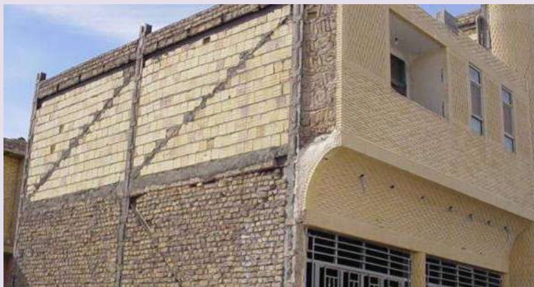
اثر مثبت دیوار در اصلاح رفتار بادبندهای نامناسب
