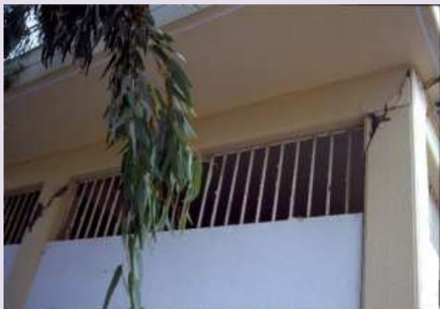
شکل ۱-۸۳- شکست ستون به علت اندرکنش با دیوار پرکننده
