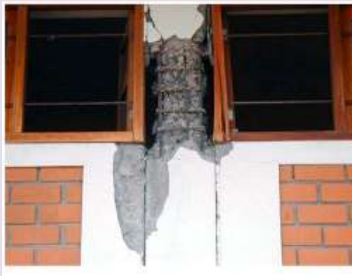
شکل ۸۱-۱- نمونه‌ای از شکست ستون کوتاه
