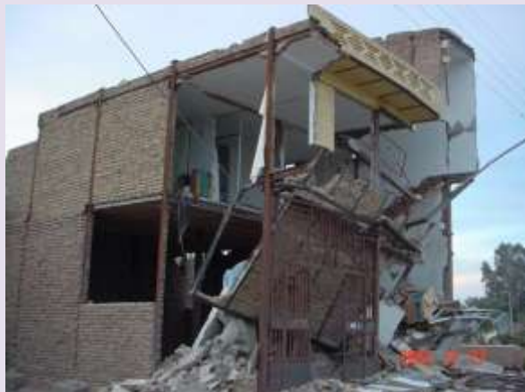
شکل ۱-۶۰- شکست خارج از صفحه دیوار پرکننده
