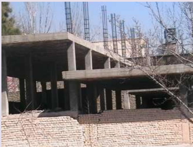
شکل ۱-۸۹- پتانسیل شکست ستون کوتاه
