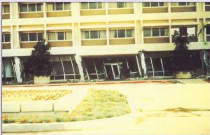
تغییر شکل ناشی از طبقه نرم
