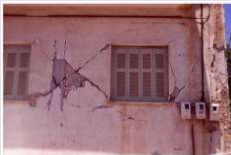
شکل ۱-۶۷- شکست برشی ستون کوتاه با وجود
