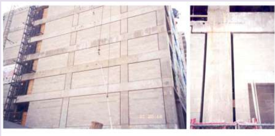
شکل ۱-۹۶- فاصله بین دیوار پرکننده با قاب
