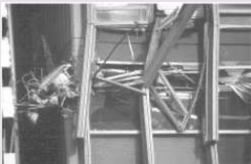
نمای نزدیک از خردشدگی طبقه فوقانی یک ساختمان اداری (Kobe, Japan 1995)
