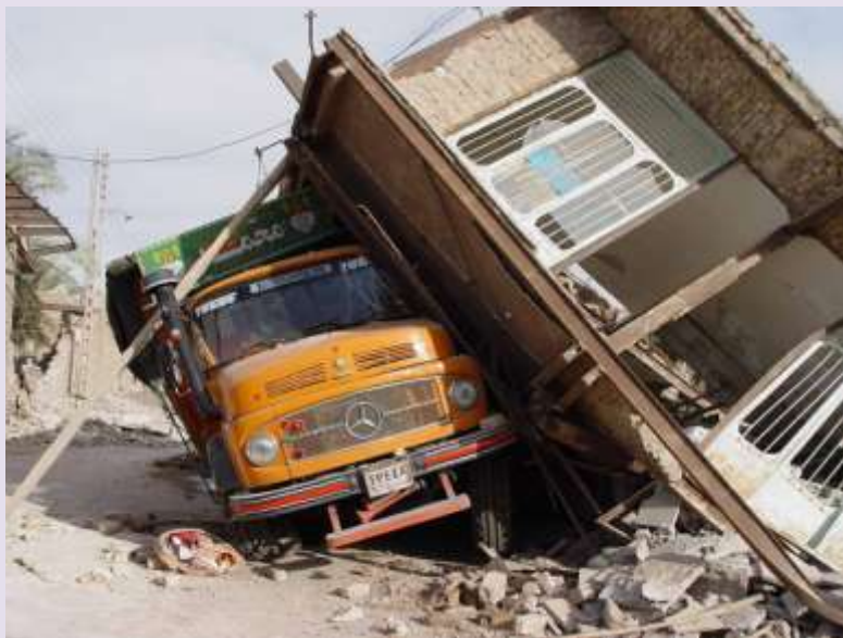
شکل توأم طبقه نرم و پیچش
