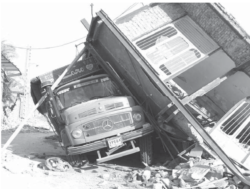
شکل ۵۰.۱ شکست توأم طبقه‌ی نرم و پیچش (بم، ۱۳۸۲)
