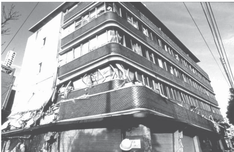
شکل ۴۹.۱ تخریب یک ساختمان به علت نادیده گرفتن اثر سختی دیوار (کوبه، ۱۹۹۵)
