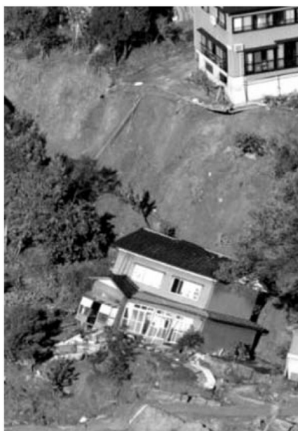
شکل ۱۲.۴ ناپایداری شیب (نیگاتا، ژاپن، ۲۰۰۴)
