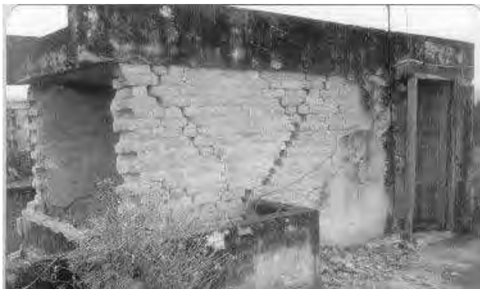
شکل ۴۴.۲ ترک ضربدری در دیوار باربر (هند)
